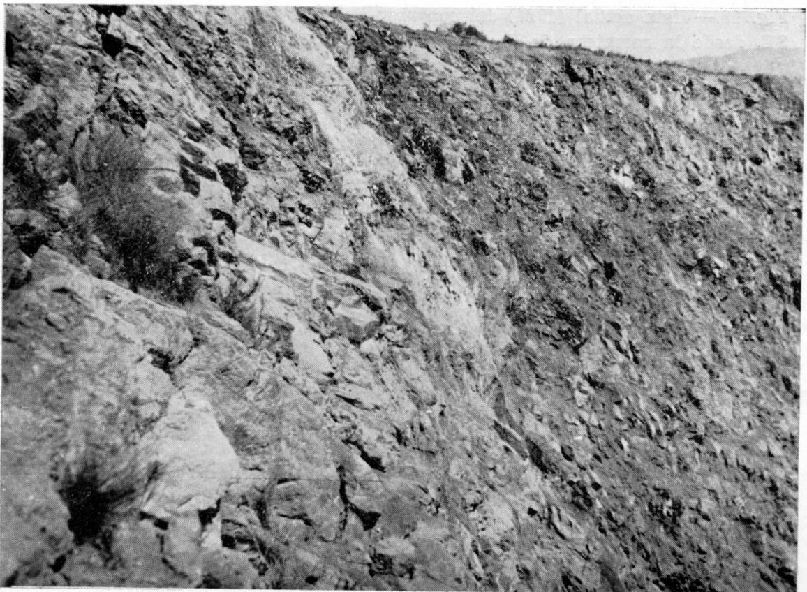
Fig. 12.—Detalle de la falla de la cantera n.º 4. Se distingue perfectamente el material no fallado y los materiales caídos y caóticamente dispuestos.
