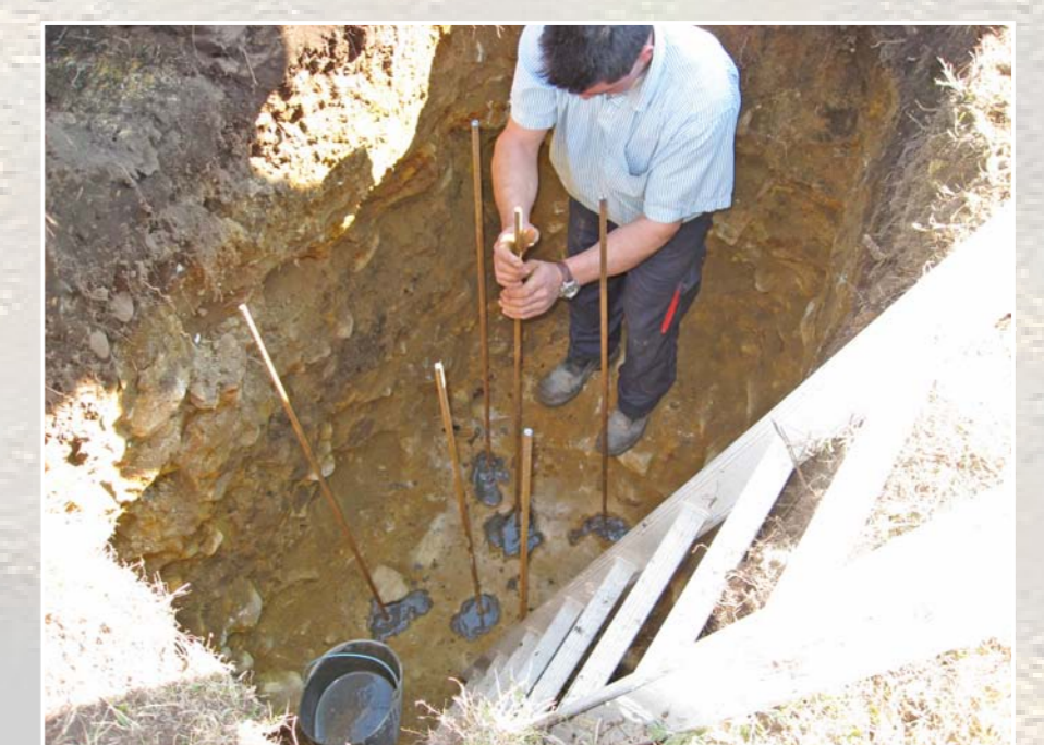
Inicio de la cimentación
