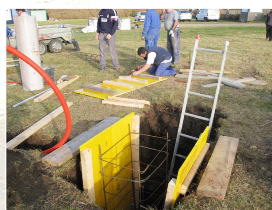
Encofrado para la cimentación
