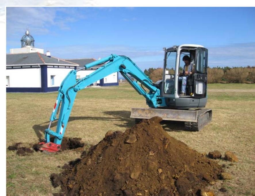
Excavación para la cimentación
