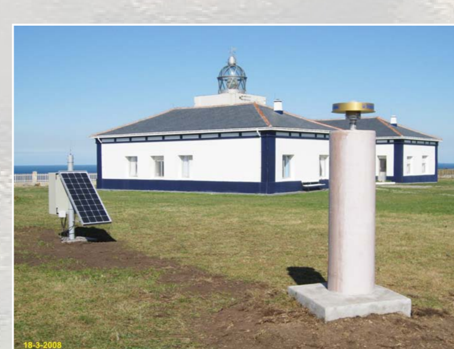
Instalación definitiva de la estación CABU (Asturias-N Península)
