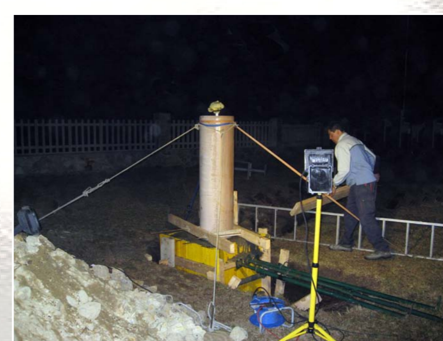
Construcción del cilindro de hormigón
